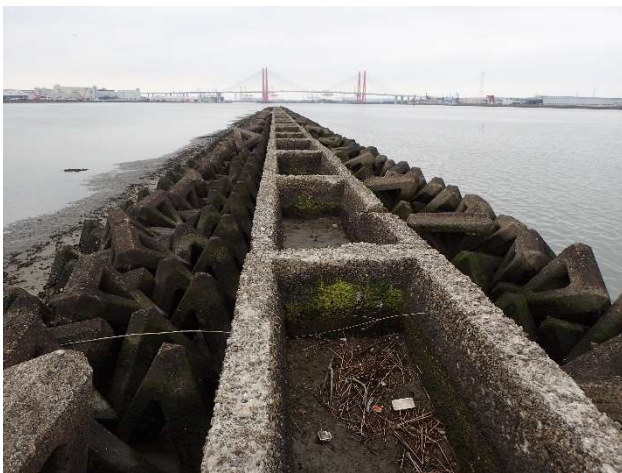
図34 庄内川河口の導流堤 左が庄内川 右が新川
